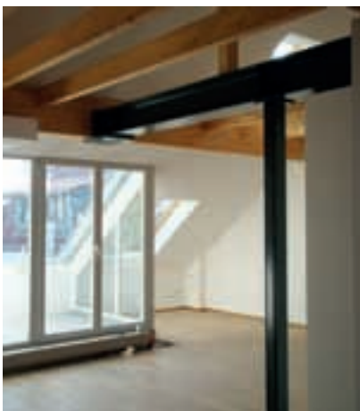
Denkmalschutz und Wohnkomfort passen zusammen: wärmeisolierte Altbauten
