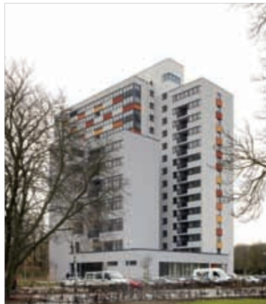
Frankfurt am Main, Sandhöfer Allee Modernisierung eines Hochhauses der 1950 Jahre Bauherr: Gbr IJAF Blodinger, Frankfurt am Main Planung: schneider+schumacher, Bau- und Projektmanagement GmbH, Frankfurt am Main
