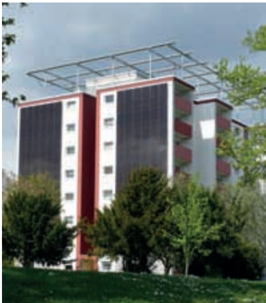
Hanau, Dresdener Straße Modernisierung und Umbau Wohnsubstanz 1970er Jahre Bauherr: Bau- u. Siedlungsgenossenschaft Bünde Planung: B&S; Dipl.-Ing. Florian Ohmes, Bünde
