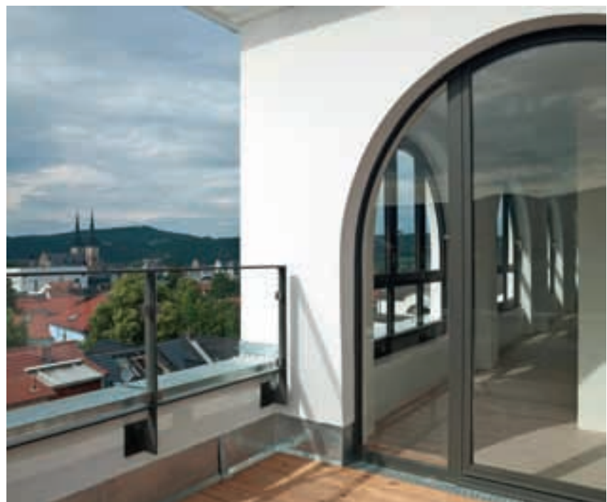
Loggien als energetische Pufferzone
