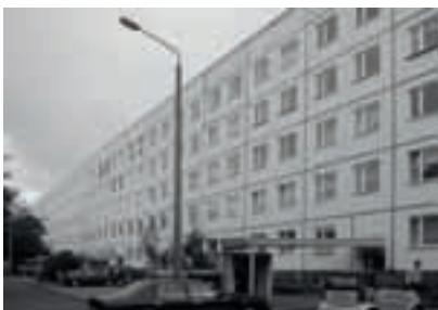
Straßenansicht vor der Modernisierung
