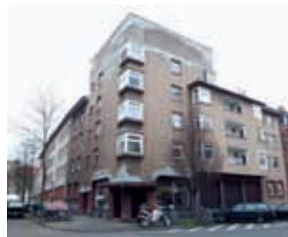
2006: stark sanierungsbedürftig; Beginn der tiefgreifenden Erneuerung
