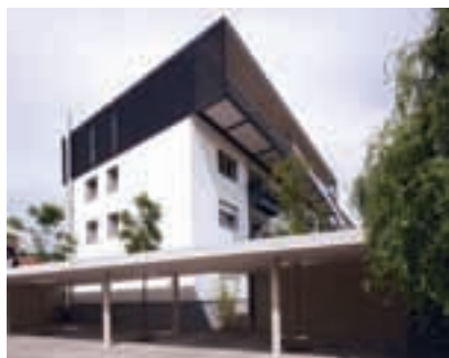
Im begrünten Carportdach ermöglichen runde Aussparungen die Pflanzung von drei großen Straßenbäumen.
