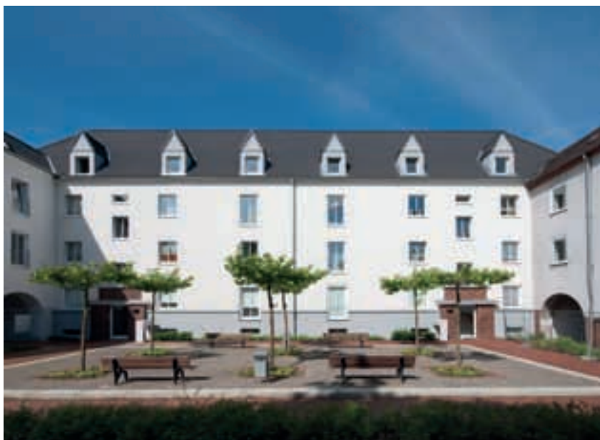
Die Gebäude erhalten Sprossenfenster und um die Fassade läuft als charakteristisches Merkmal ein Gesimsband. Beide Elemente entsprechen dem Stil der Entstehungszeit des Karrees.
