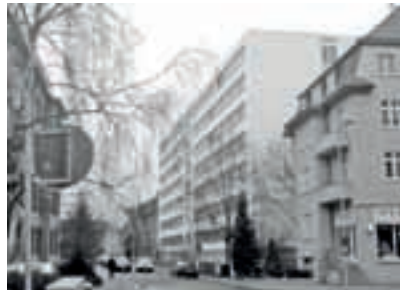
Skelettbau aus den 1970er Jahren
