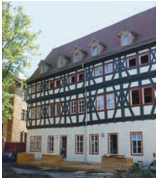
Erfurt, Drachengasse Speicherbau aus dem 16. Jahrhundert Bauherr: Projektentwicklung Niedling, Erfurt Planung: „die bauhütte“, Mühlhausen
