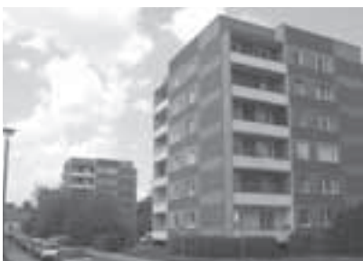
Bestandsgebäude vor der Sanierung
