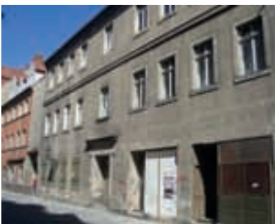
Umnutzung einer Bauruine zu einem internationalen Bildungsstandort
