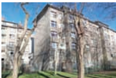
Bestand vor der Sanierung
