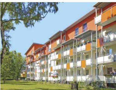
Modernisierung auf Niedrigenergiestandard: Der Heizwärmebedarf konnte reduziert werden von 300 kWh/m 2 /a auf 45 kWh/m 2 /a.
