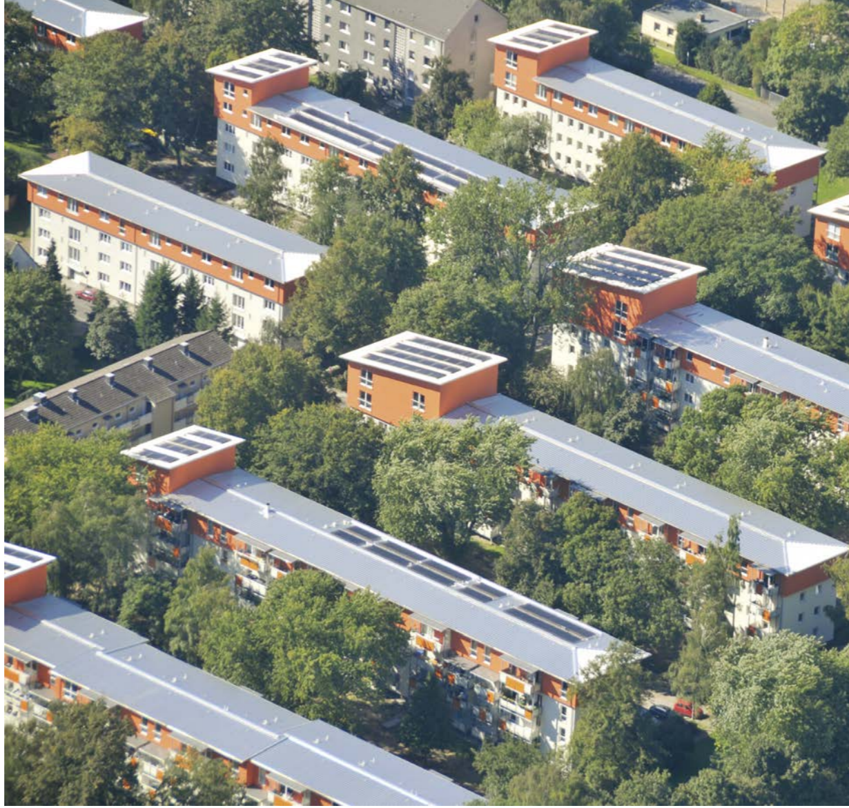
Beispiel Köln, Fordsiedlung: 75 Prozent der Bewohner sind in der Siedlung nach der energetischen Sanierung wohnen geblieben.
