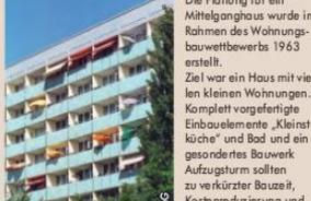
Mit Q3A begann 1957 die Serienproduktion der Großblockbauweise in Berlin. Es handelt sich per Definition noch nicht um „Plattenbau“, eine Wand bestand noch aus mehreren einzelnen Beton-elementen.
