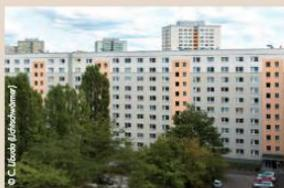
Beim QP wurden erstmals in der DDR raumgroße Elemente verwendet, d. h. die Gebäude sind „Plattenbauten“ aus industrieller Fertigung. Markant sind die außenhängig verwendete Keramikplatten. Die beiden Gebäude Sevanstraße 173-179 und 209-219 werden seit Erstbezug als Studentenwohnheim genutzt und wurden auch zu diesem Zweck gebaut. Den privaten Zimmern sind gemeinschaftlich genutzte Küchen und Duschbäder zugeordnet. Einzelne Zimmer haben Zugang zu einem eigenen Balkon.
