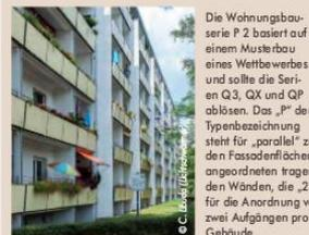
Die Wohnungsbauweise P 2 basiert auf einem Musterbau eines Wettbewerbes und sollte die Serien Q3, QX und QP ablösen. Das „P“ der Typenbezeichnung steht für „parallel“ zu den Fassadenflächen angeordneten tragenden Wänden, die „2“ für die Anordnung von zwei Aufgängen pro Gebäude.
