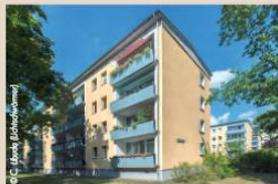
Der Bautyp QX wurde in Großblockbauweise - also nicht in Plattenbauweise - in Querwandbauweise mit Achsabständen zwischen 2,40 m und 3,60 m gebaut.
