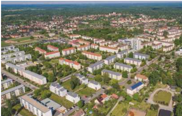
Lübbenau (WIS Wohnungsbaugesellschaft im Spreewald, Lübbenau)
