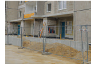
Umbau der Erdgeschosszone
