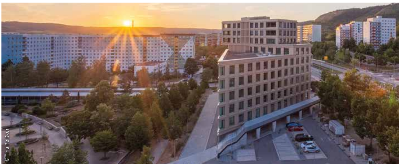
Das zehngeschossige Gebäude K1 bestimmt den Stadteingang von Lobeda-Ost an exponierter Stelle. Die ungewöhnliche Form nimmt Bezug auf die Topografie und den umgebenden Lobdepark.
