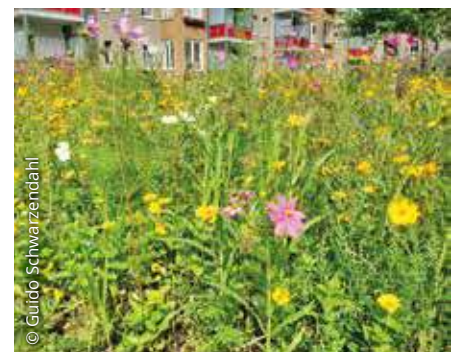
Unmittelbar nach dem Verlegen der Nahwärmeleitungen wurden Blumenwiesen angelegt.
