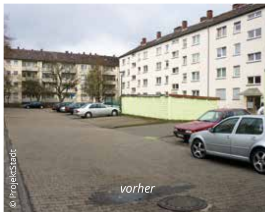
Vorher – nachher: Anstelle des tristen Parkplatzes ist eine neue Mitte entstanden. Der Bürgertreff wurde an den neuen Standort umgesetzt und neugestaltet.
