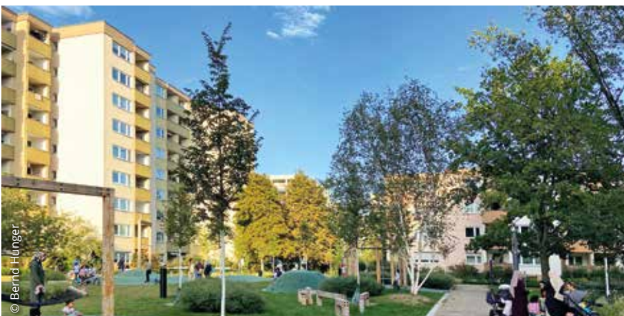
Das Wohnumfeld des benachbarten Innenhofes wurde als Aufenthalts- und Spiellandschaft neugestaltet.
