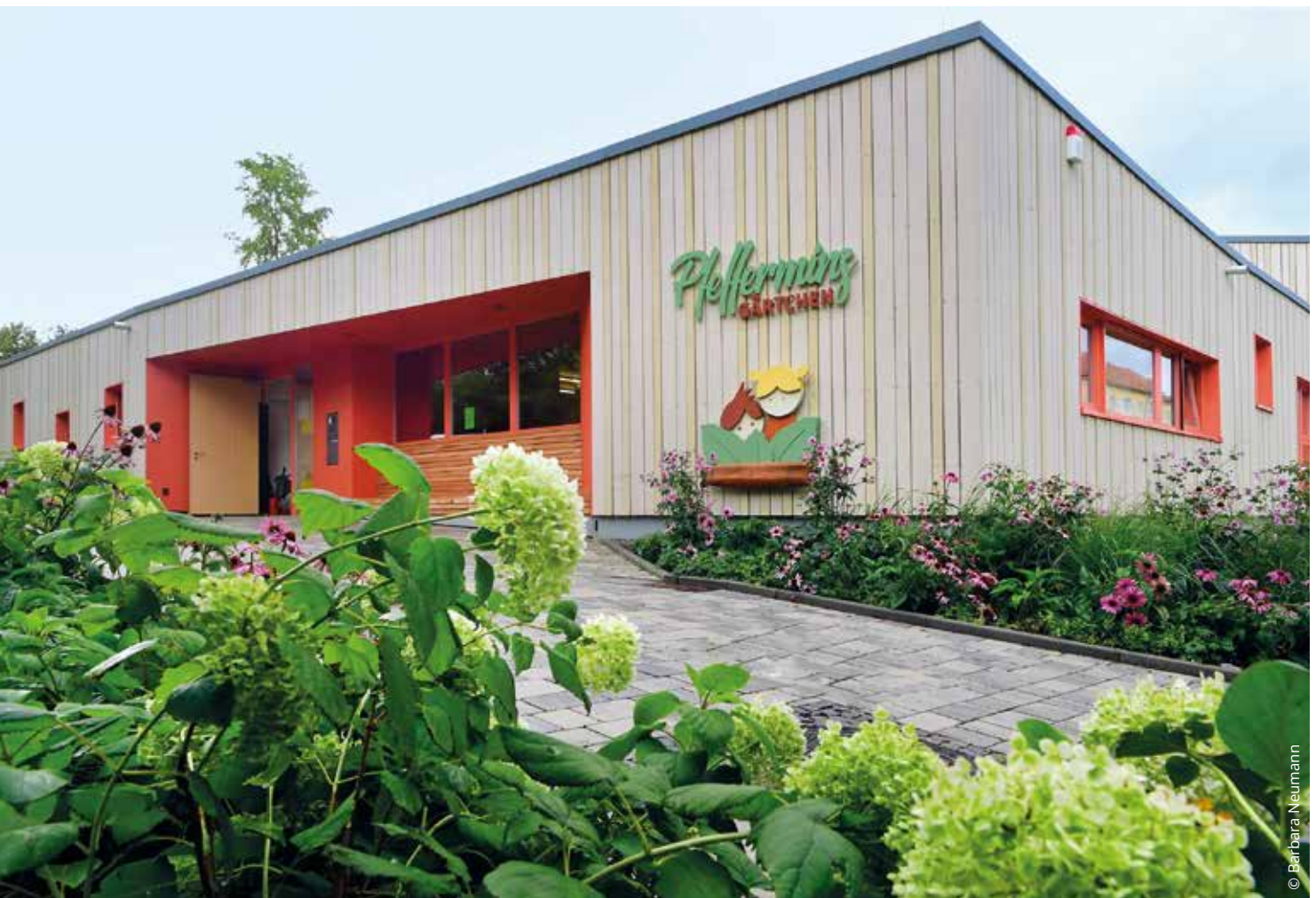
Der einladende Eingangsbereich des komplett aus Holz errichteten Baus
