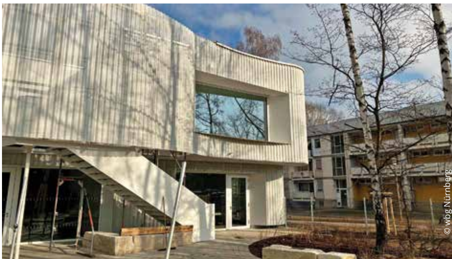
Neuer Kinderhort an der Striegauer Straße. Die geschwungene Blechbekleidung schafft die Ausstrahlung einer weichen, beherbergenden Form als Haus für die Kinder.
