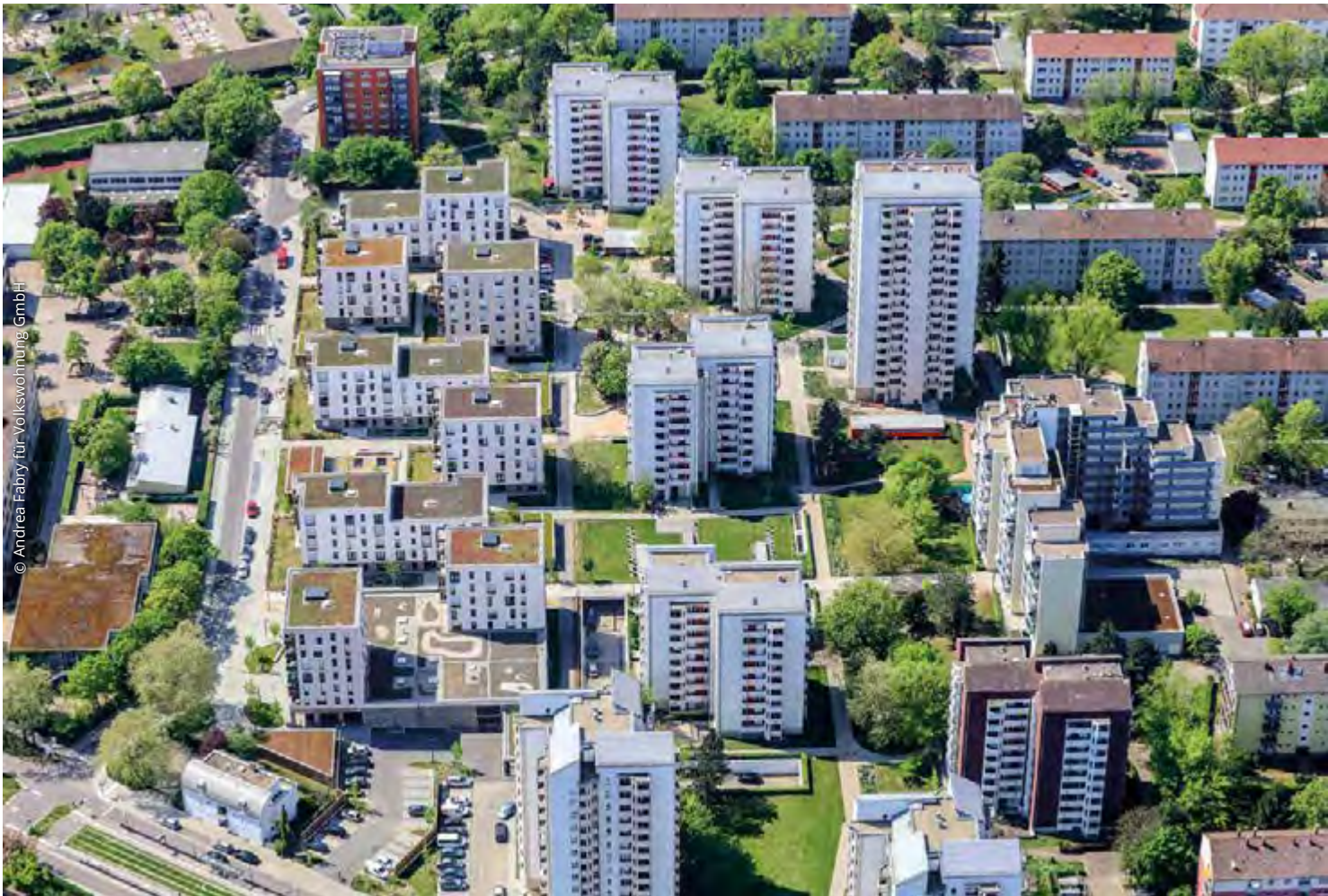
Neubau in der Großsiedlung Rintheimer Feld, Karlsruhe
