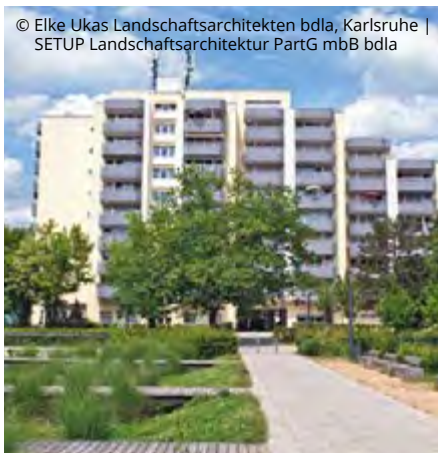
Der Bereich vor den Hochhäusern wurde zur autofreien Zone.
