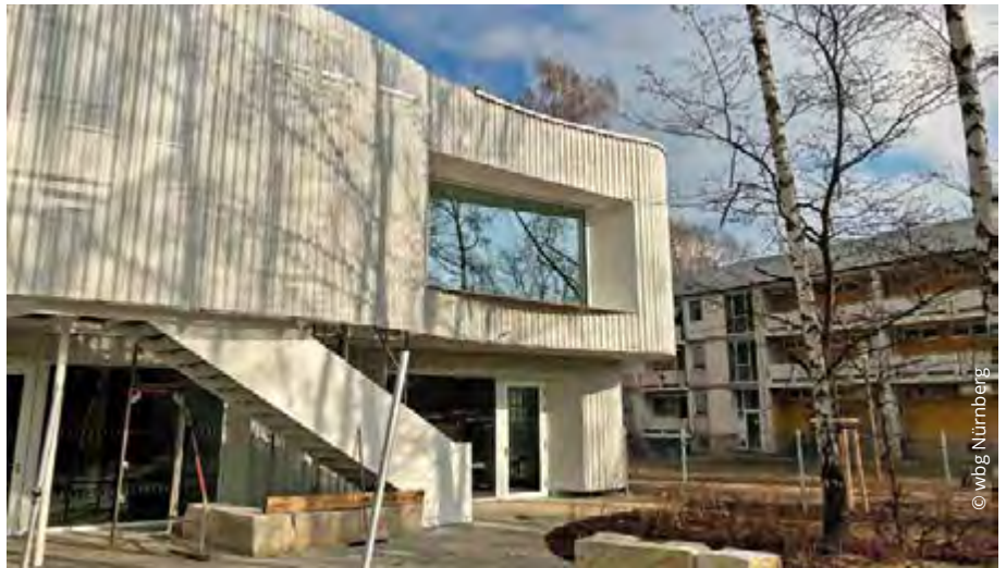
Neuer Kinderhort an der Striegauer Straße. Die geschwungene Blechbekleidung schafft die Ausstrahlung einer weichen, beherbergenden Form als Haus für die Kinder.
