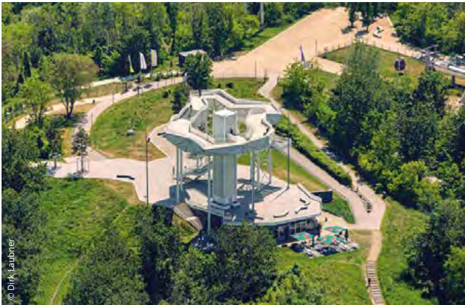
Zwischenstation am Wolkenhain, Aussichtsbauwerk mit einem Panorama-Café
