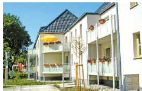
Bei fast allen Wohnungen wurden Balkone nachgerüstet.
