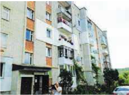
Sanierung der Wohnhäuser dringend notwendig
