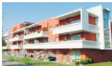
Rückbau auf drei bzw. vier Geschosse; Neugestaltung der Balkone und Terrassen
