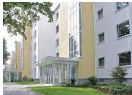
Seniorengerechte Anpassung der Wohnungsangebote durch Anbau von Fahrstühlen
