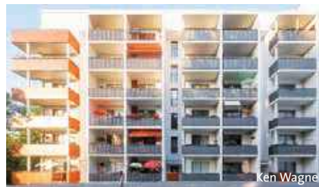
Sanierte Wohnhäuser auf der Mittelachse: Seniorengerechtes, barrierefreies Wohnen (Anbau von Aufzügen und Balkonen, Grundrissveränderungen der Wohnungen)
