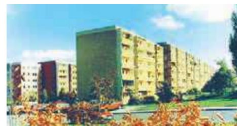
'Kräutersiedlung': Bestandsgebäude vor der Modernisierung
