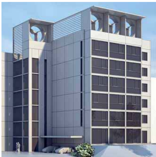
Gebäudeintegrierte Kleinwindkraftanlagen: Eine mögliche Alternative für die Energieerzeugung von Ort. Quelle: EA Energie-Architektur
