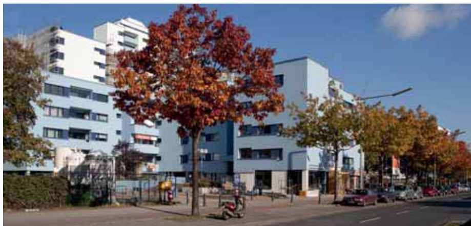
Die Wohnhausgruppe 905 am Wilhelmsruher Damm befindet sich derzeit im Bau. Quelle: GESOBAU AG
