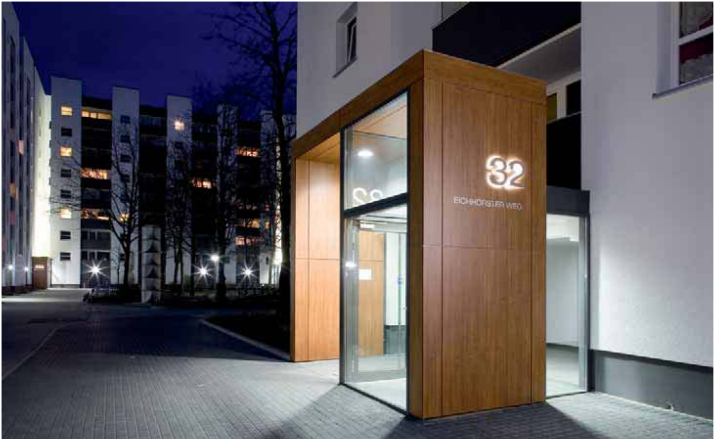
Hellere Hauseingänge sorgen für eine bessere Orientierung im Wohngebiet.
