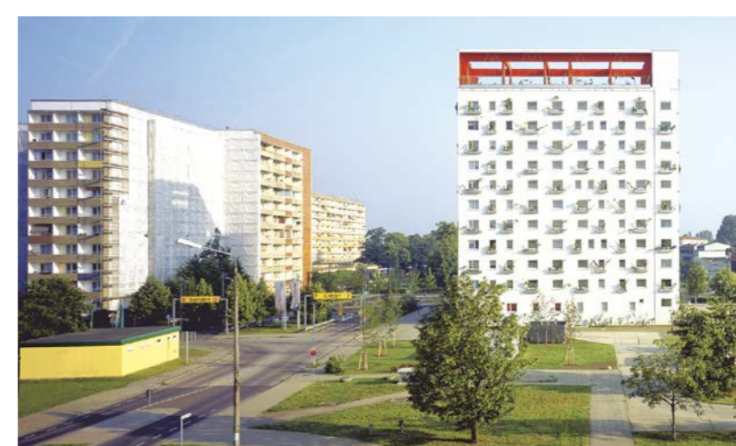
Hoyerswerda: Lausitzturm - Transformation eines Plattenbau-Hochhauses
