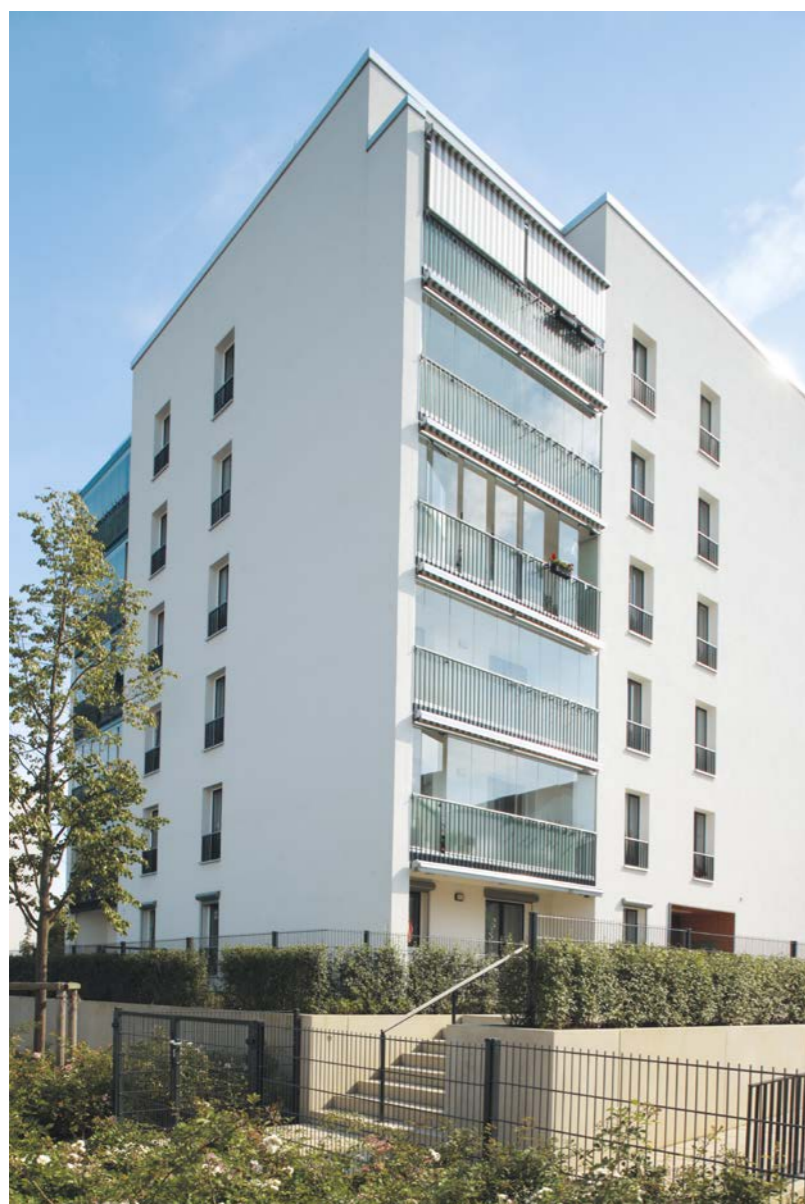
Senftenberg: Barrierefreie Erschließung der Erdgeschosszone und Zuordnung von Terrassen und kleinen Mietergärten
