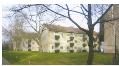
Gebäudebestand 1950er Jahre vor der Modernisierung
