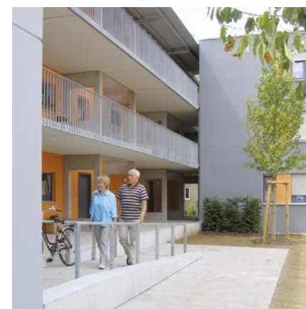
Barrierefreie Zugänge zu den Wohnungen
