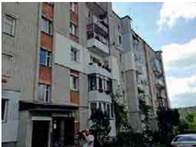
Ansicht des Wohnhauses Yarovnickovo Str. 8 im Modellprojekt Zhovkva. Ein typisches Beispiel mit in Eigeninitiative gedämmten Fassadenbereichen und Fenstererneuerungen durch die Wohnungseigentümer
