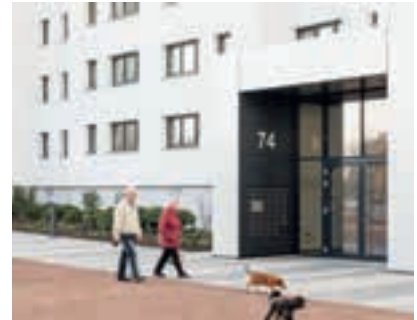
Umbau zum Haupteingang 2017
