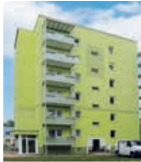
nach dem Umbau
