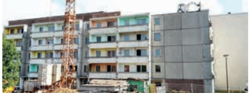
Teiltrückbau und Entkernung des Gebäudes
