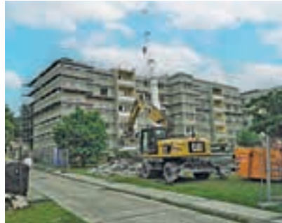
Rückbau von Geschossen
