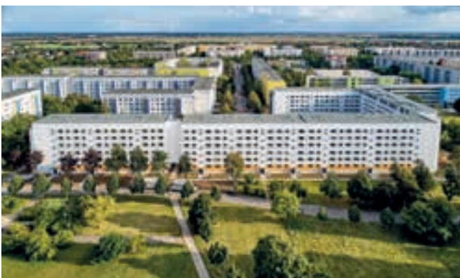
Moderne Wohnanlage mit ebenerdigen Hauseingängen und auf Wohnebene haltenden Aufzügen.
