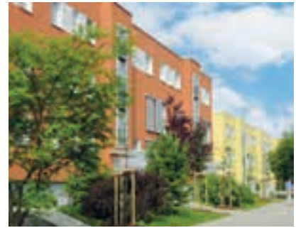
nach dem Umbau 2002
