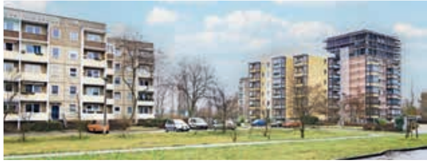
Während der Umbauphase
