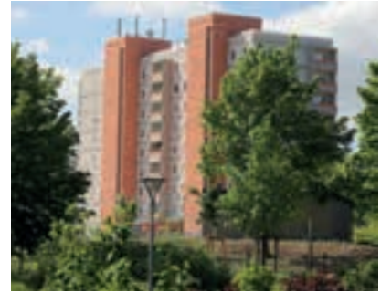
Fassaden- und Balkonsanierung
