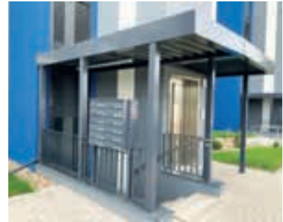
Barrierefreier Zugang zum Aufzug
