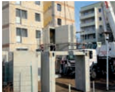
Einbau des neuen Treppenhauses
