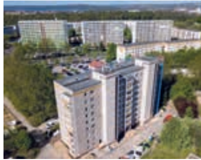
Umbau und Modernisierung
