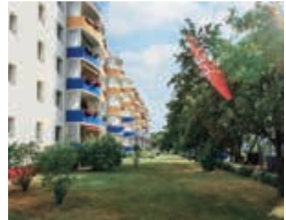
Anbau von neuen Balkonen
