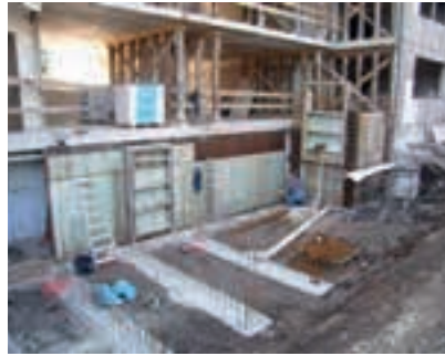
während des Umbaus
