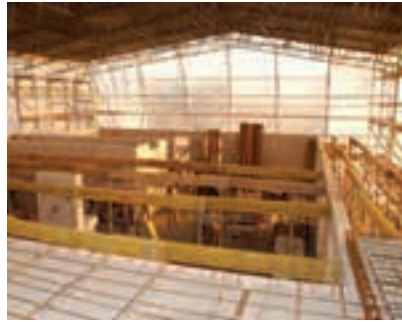
Konstruktion der Dachaufstockung
