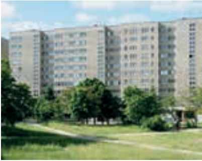
Bestand vor dem Umbau
