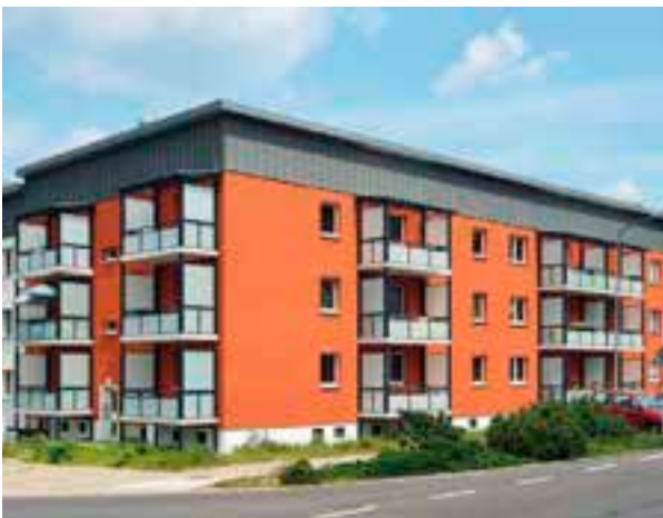
Die Mieter konnten während der Umbauarbeiten wohnen bleiben.
