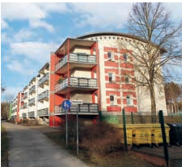
Neue Dachform und Balkone an der Giebelseite
