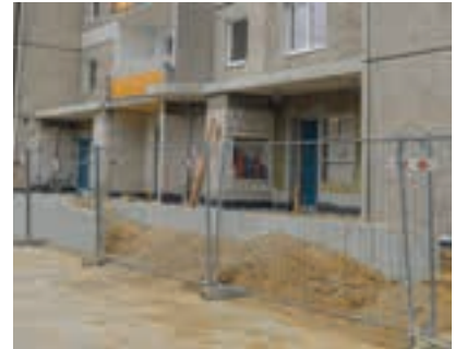
Umbau der Erdgeschosszone
