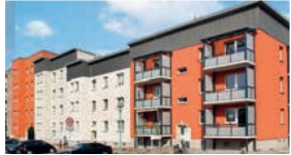
Erneuerung und Anbau von Balkonen
