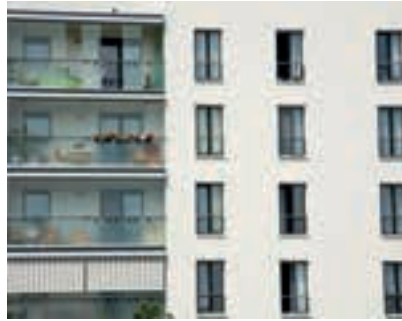
Balkone mit Glasfassaden
