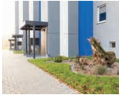
Ereuerung der Eingangsbereiche
