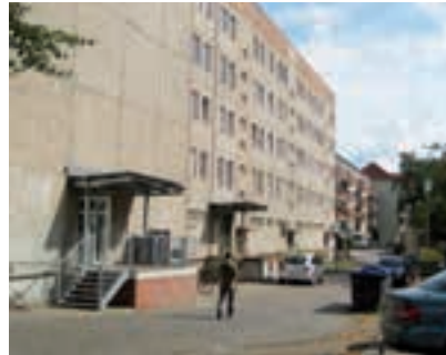
Hofseite: vor dem Umbau
