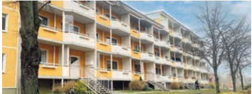
Erneuerung und Anbau von Balkonen
