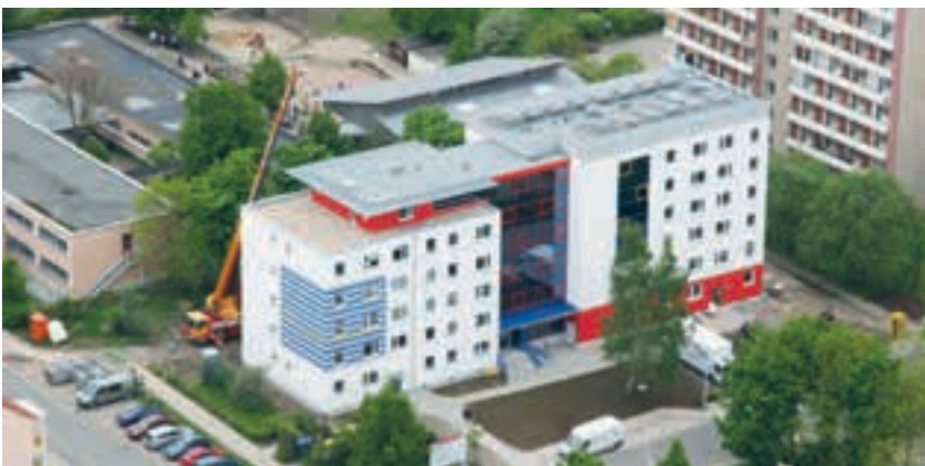
Blick auf die Solaranlage zur Unterstützung der Warmwasserversorgung
