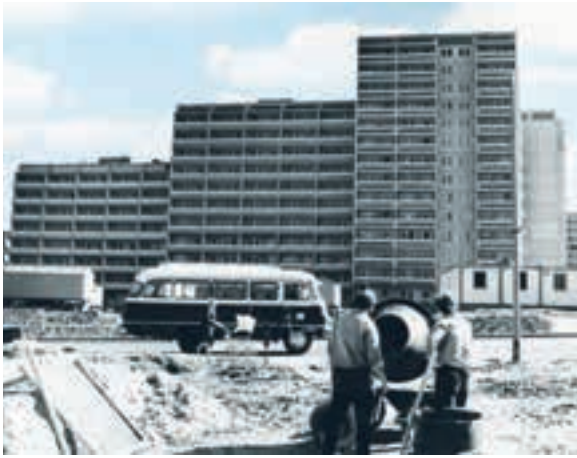
Bau des Stufenhochhauses
