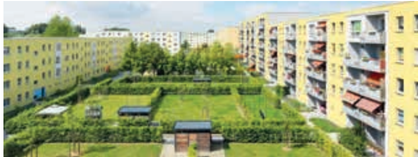
Erneuerung der Wohnumfelder
