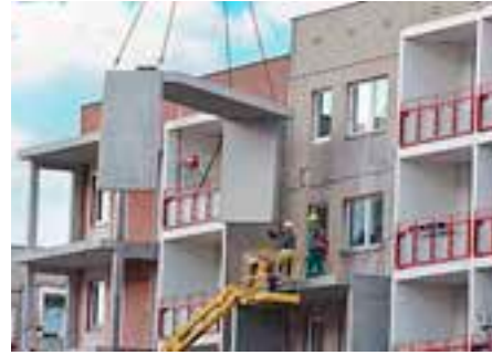
Anbau von Balkonen
