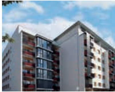
Glaserker und Aufstockung im 4. Bauabschnitt
