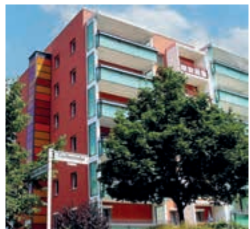
Anbau von Balkonen
