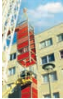
Anbau von Aufzügen
