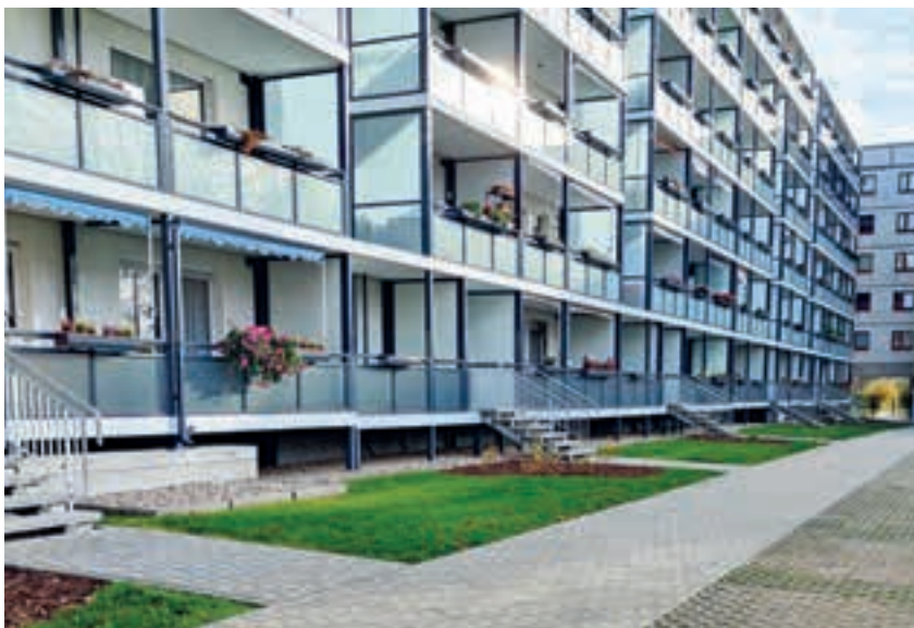
Vorgärten auf der Balkonseite und Feuerwehrumfahrung
