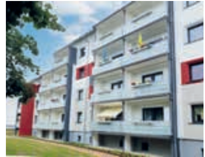
Anbau von neuen Balkonen
