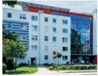
nach dem Umbau
