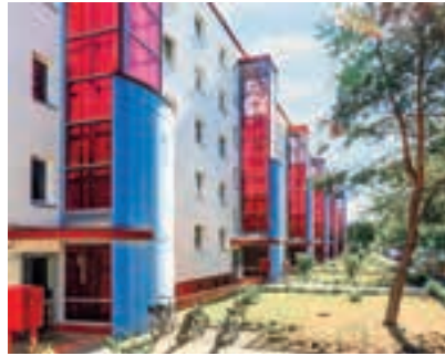
Anbau von gläsernen Aufzügen
