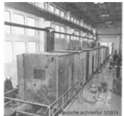
Komplettierungslinie für Sanitärraumzellen
